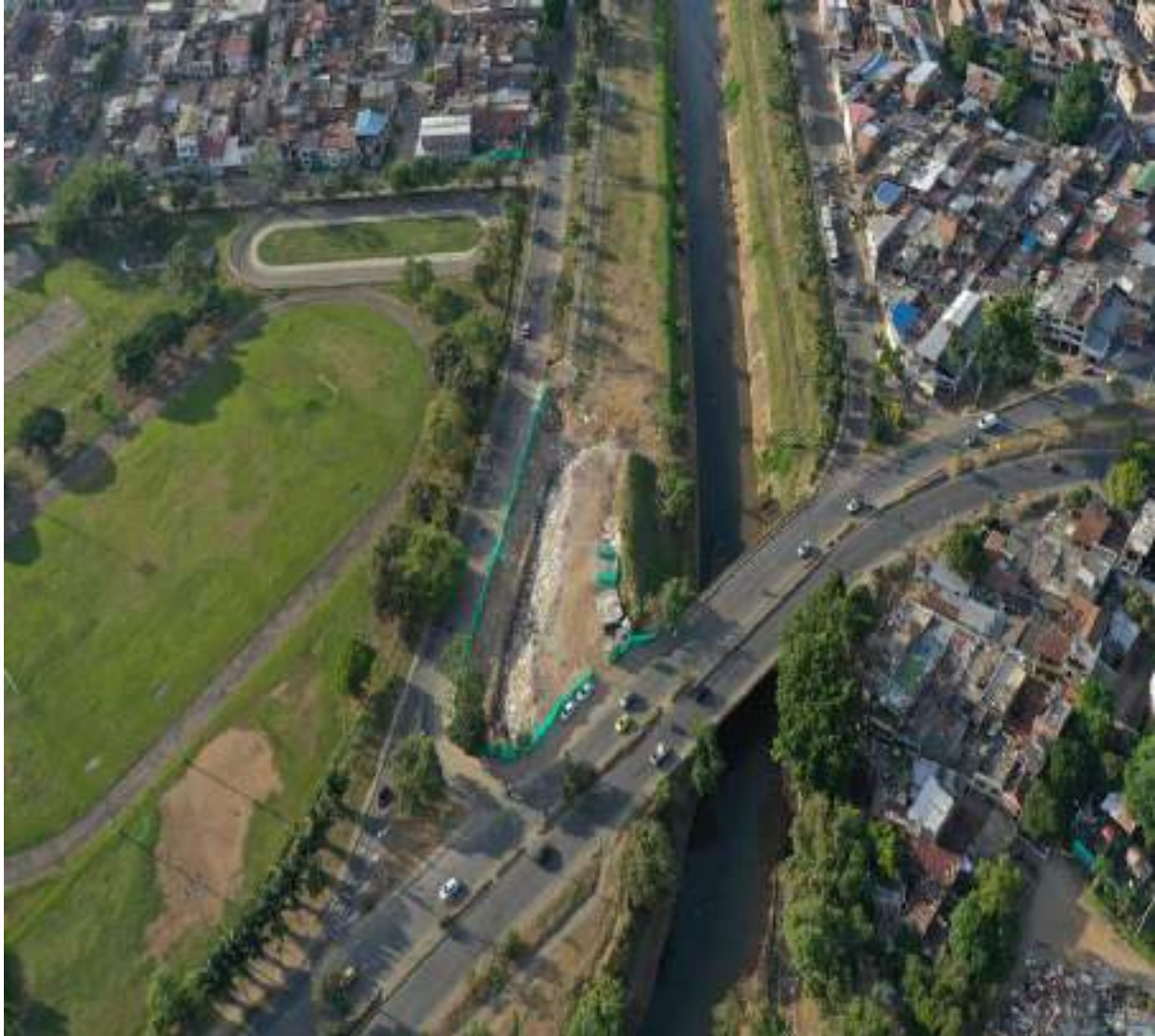
Ilustración 27. Programa de Gestión de Residuos de Construcción y Demolición
